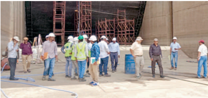
మేడిగడ్డ పనులను సోమవారం పరిశీలించిన ఇఎన్‌సి బృందం
